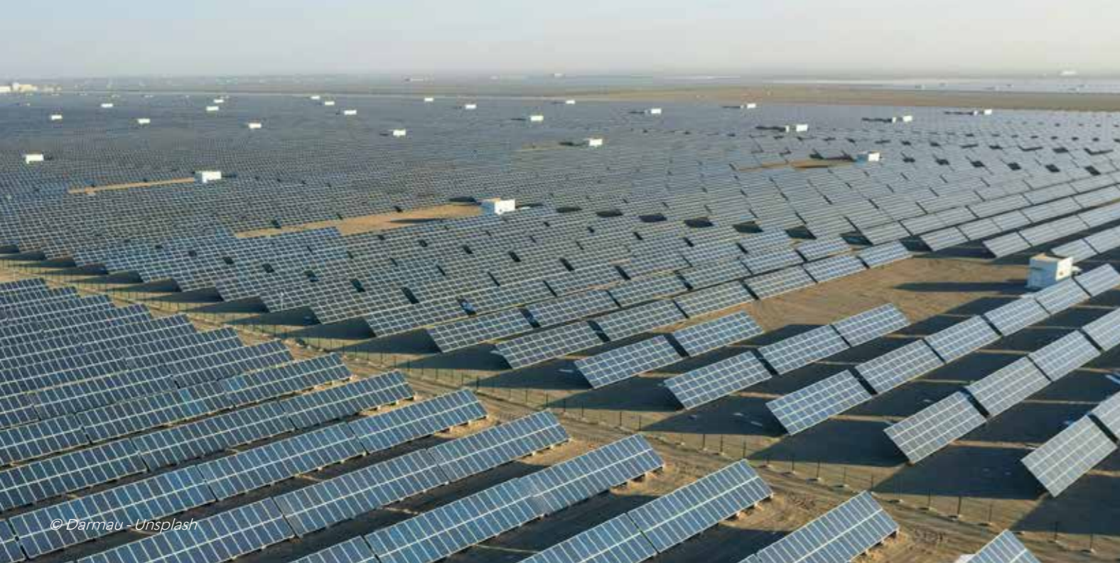
Chaque section d'une installation photovoltaïque est associée à un convertisseur de puissance, ces structures blanches disposées de façon régulière dans cette centrale de Dunhuang en Chine.
